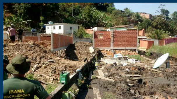
Edificações em áreas alagáveis
