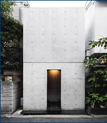
Fachada harmônica respeitando o regramento
